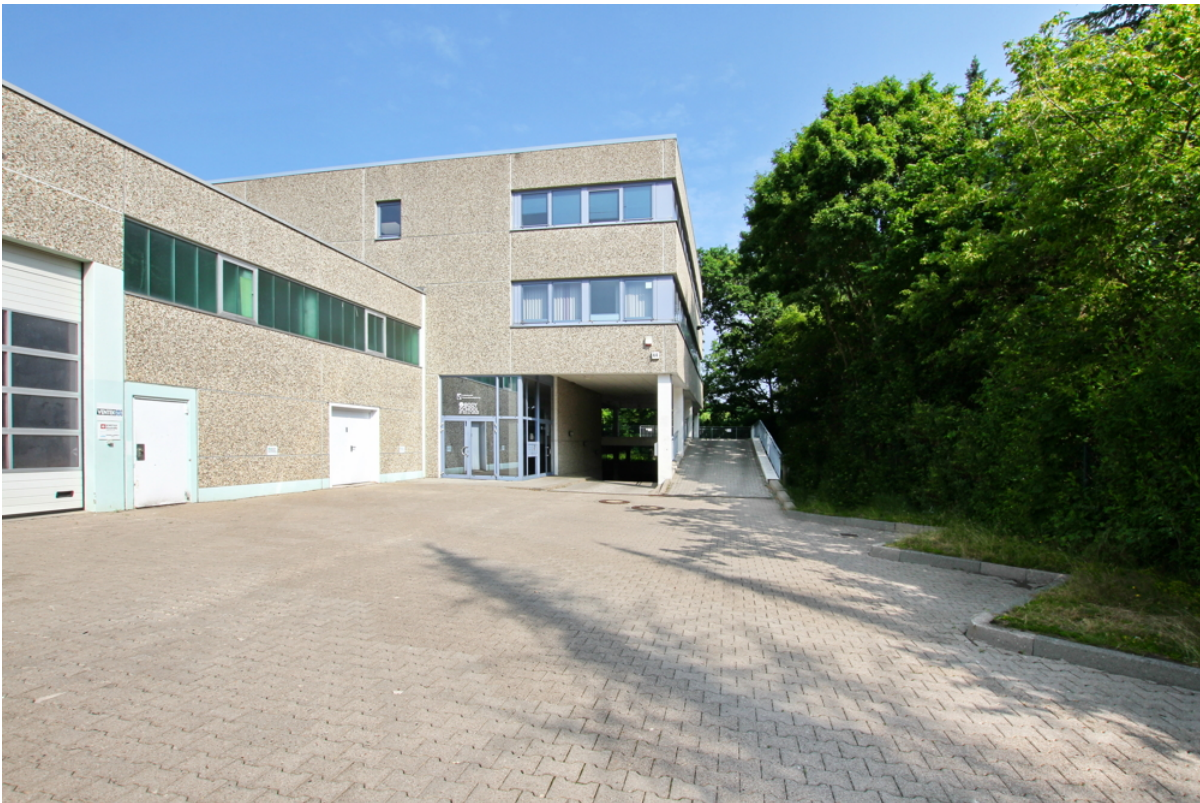
Gebäudeansicht mit Zufahrt
