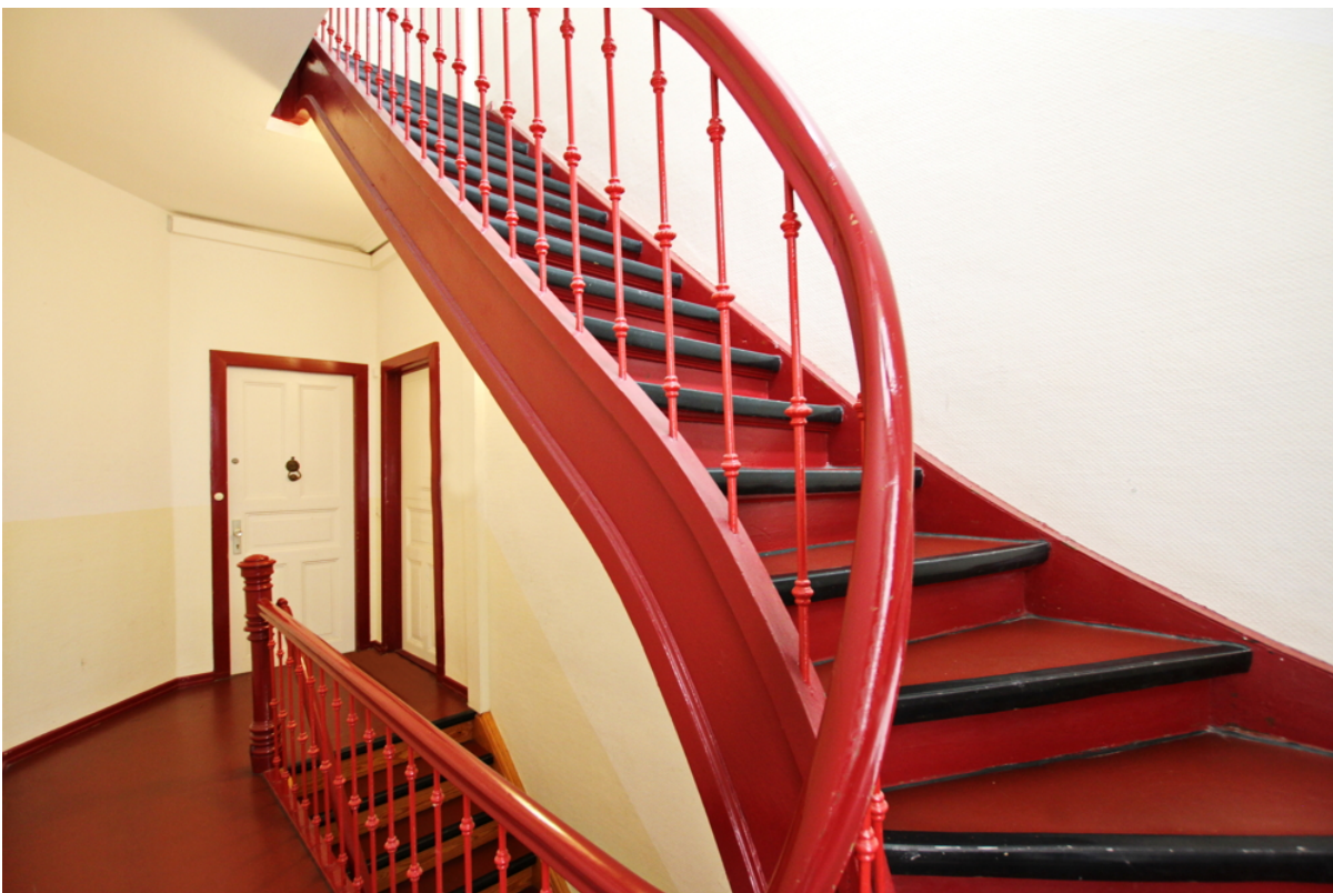
gepflegtes und gut belichtetes Treppenhaus
