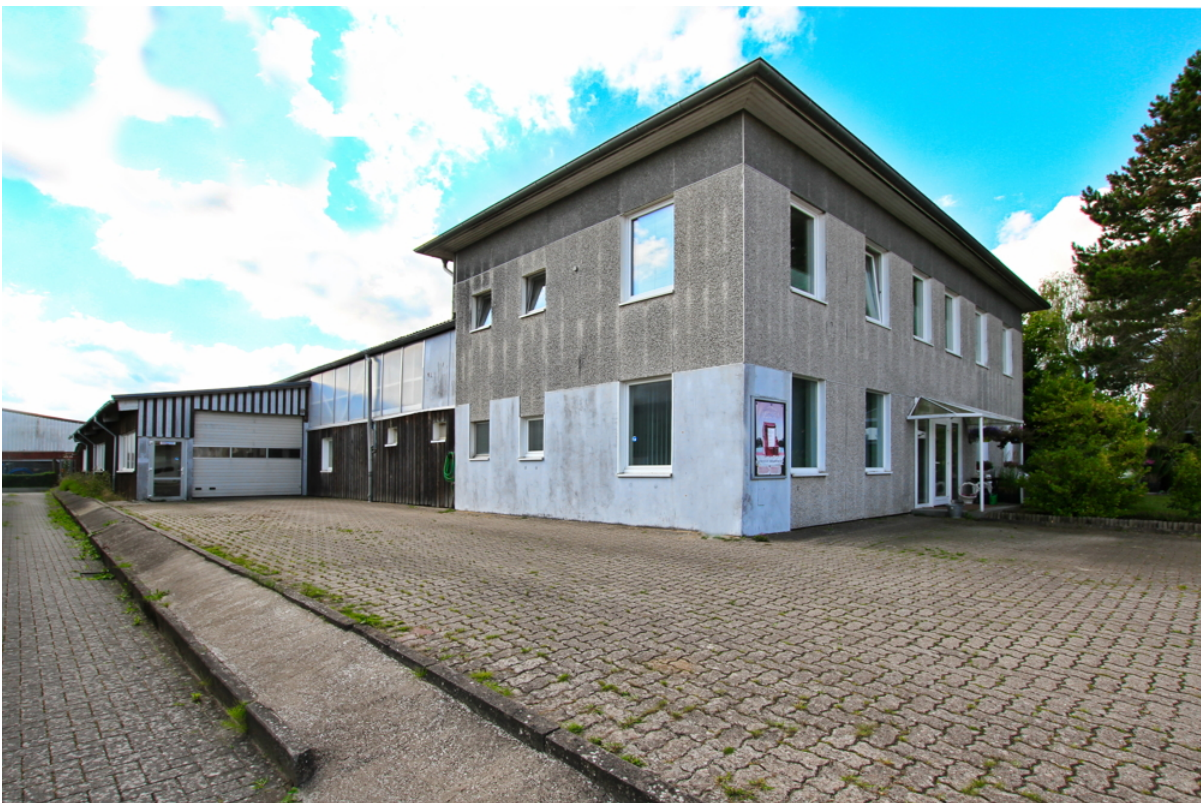
Büro- u. Hallenflächen mit ebenerdigem Rolltor
