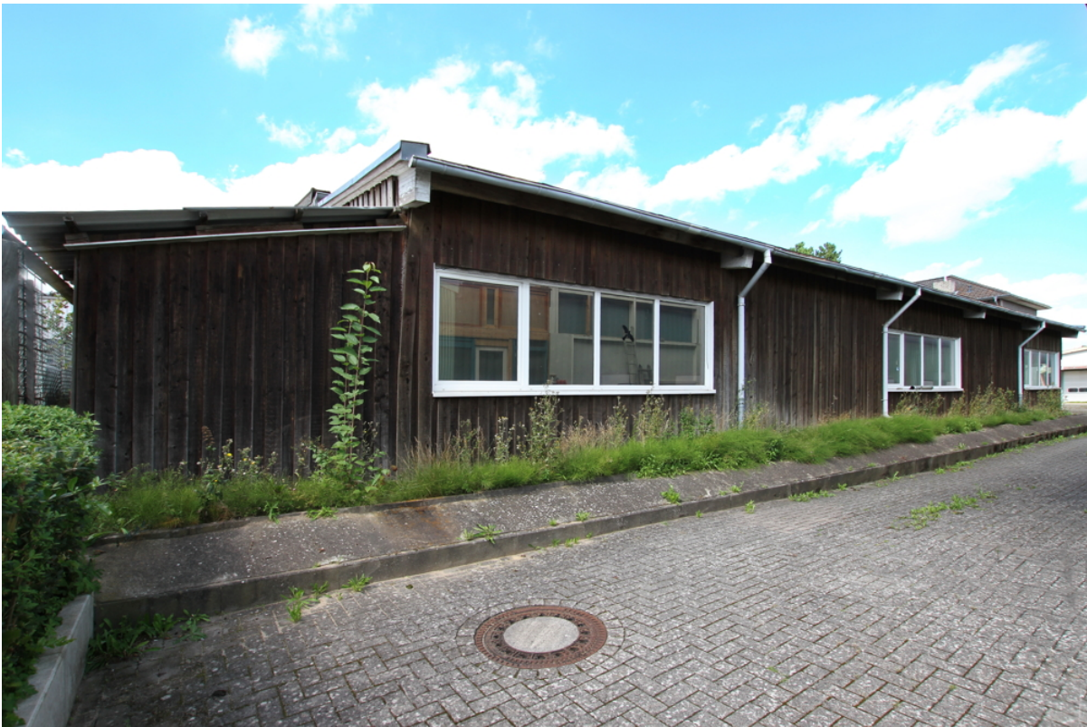
hintere Halle mit Holzfassade
