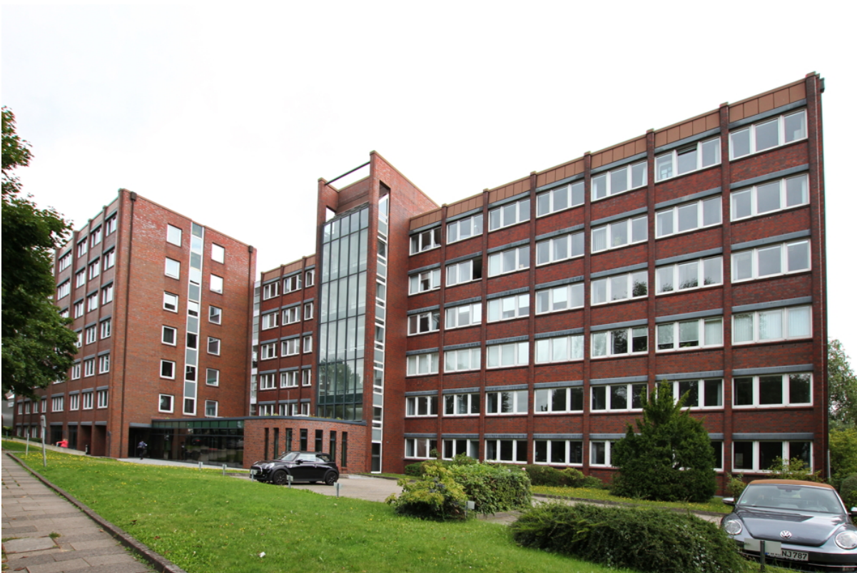
Gebäudeansicht mit Haus "a" im Vordergrund
